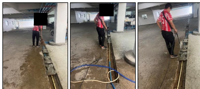
รูปที่ 3-18 เจ้าหน้าที่ชุดลอกตะกอนและทำความสะอาดท่อระบายน้ำภายในโครงการ
