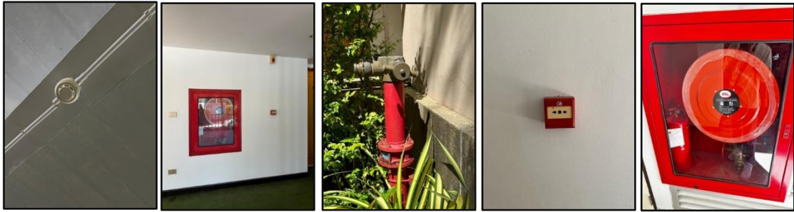
รูปที่ 3-32 ระบบป้องกันอัคคีภัย และเตือนภัยภายในโครงการ
