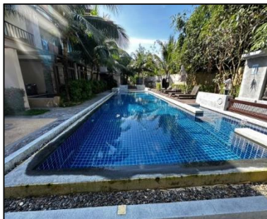
รูปที่ 3-40 วัสดุปูพื้นสระว่ายน้ำของโครงการเป็นกระเบื้องเรียบ ชนิดไม่ลื่น
