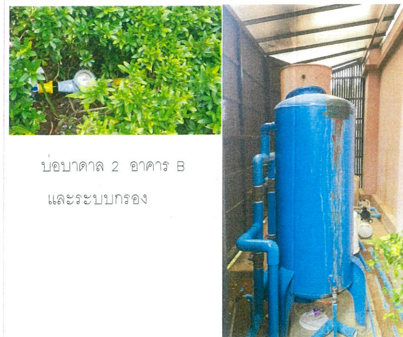
รูปที่ 2.5.1-1 แสดงตำแหน่งบ่อน้ำบาดาล และระบบจ่ายน้ำภายในโครงการ
